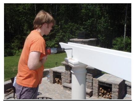
HOLD BEAMS IN PLACE AGAINST THE POST CORE WITH A CLAMP. USE EIGHT INCH LONG ½" DRILL BIT TO DRILL THRU EACH LINTEL AND THE STEEL POST CORE IN A SINGLE PASS.
